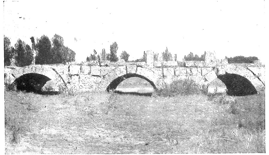
Fig. 7.—Puente romano de Tordómar.
